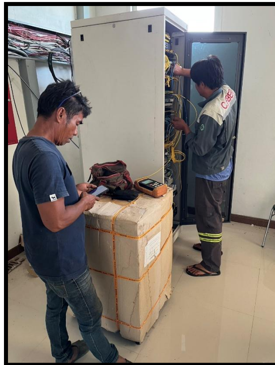
รูปการใช้เครื่องมือทดสอบระยะจุดขาดสายใยแก้วนำแสง
