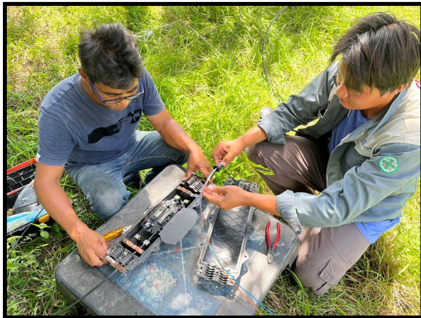
รูปการซ่อมบำรุงสายใยแก้วนำแสง
