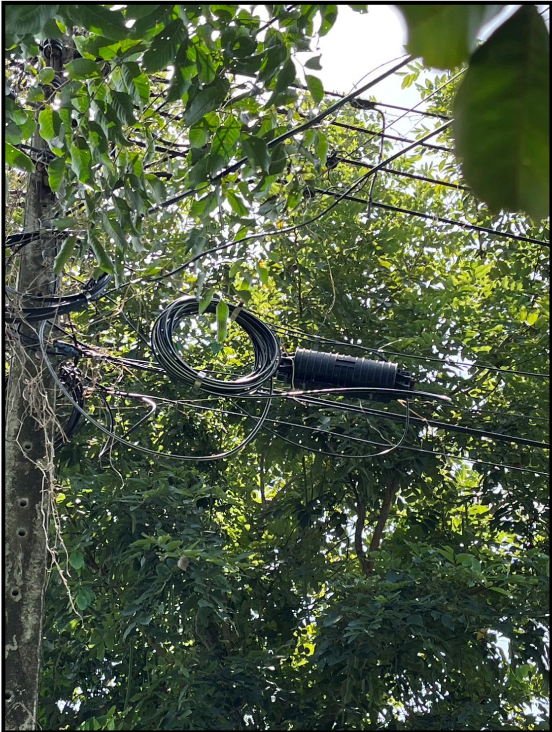
รูปการติดตั้งกล่องพักสายใยแก้วนำแสง
