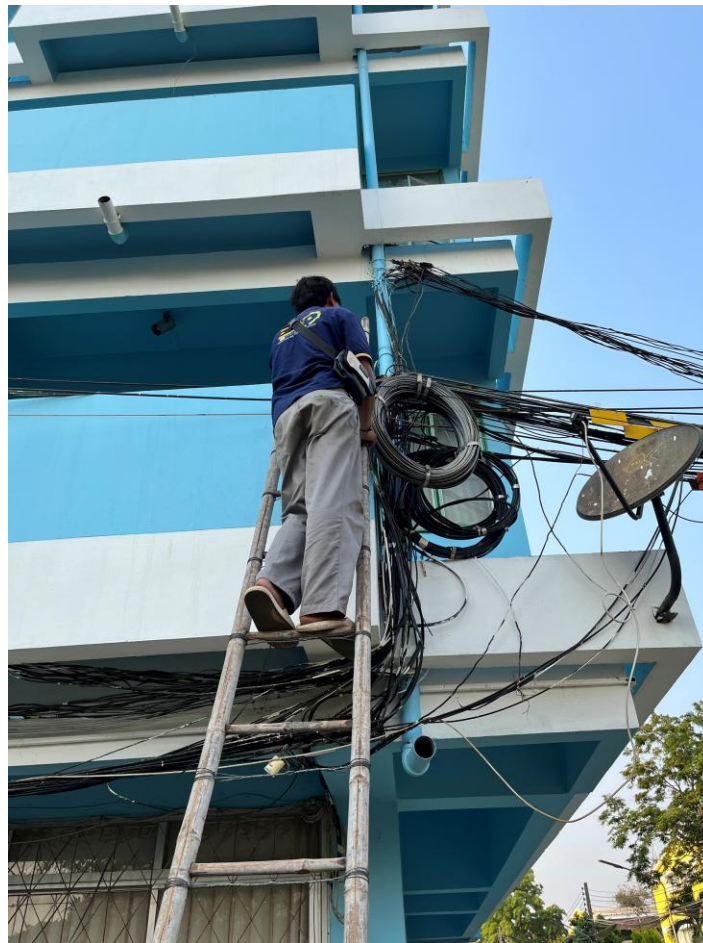
ภาพการเดินสายสัญญาณใยแก้วนำแสงใหม่ จำนวน 2 เส้นทาง
